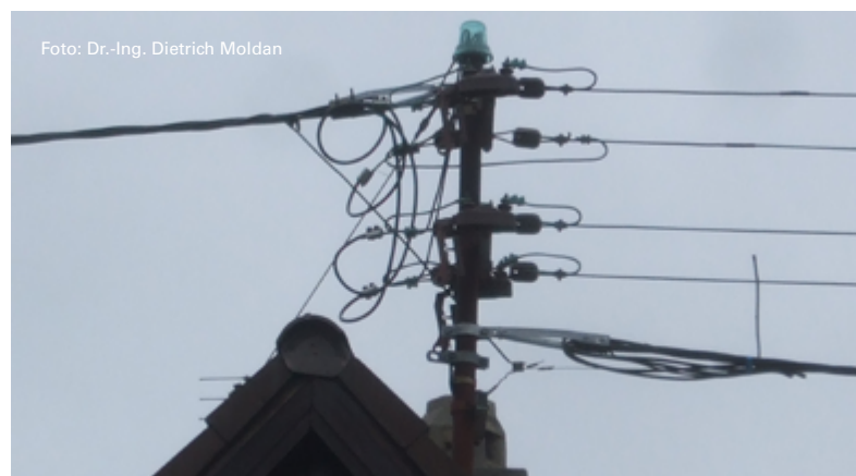
Dachständerleitung mit Übergang von Einzelverdrahtung auf Bündelleiter.
